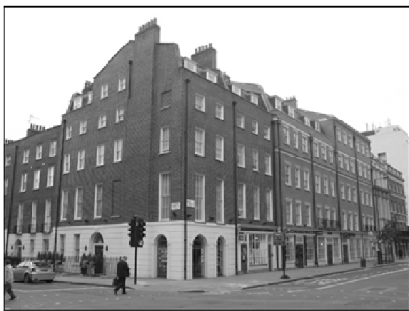
Figura 1. Londra, continuarea unui front existent în aceeași manieră constructivă
