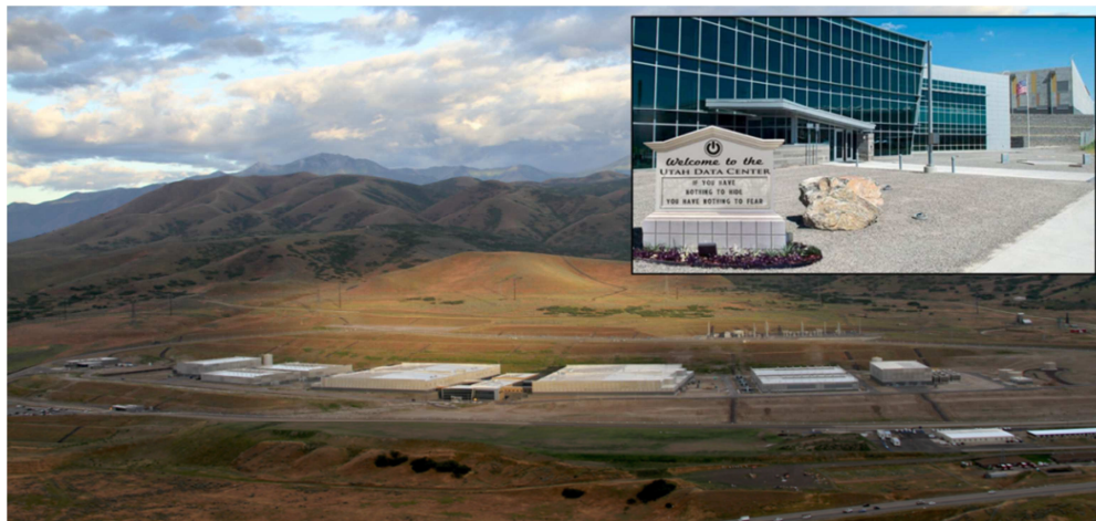
Figura 1. Utah Data Center
