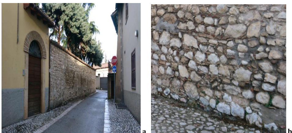
Figura 3. (a) Materiale locale: piatră, cărămidă, gresie, pavaj; (b) Detaliu din zidărie confecționat din materialele reutilizate Sursă: © Stefania Trifan, 2018
