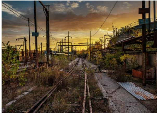
Fig. 19. Railways of the Steaua Română Refinery, Câmpina, România Source: https://proiectsteauaromana-acc.ro/ , photo: Adrian Bercaru
