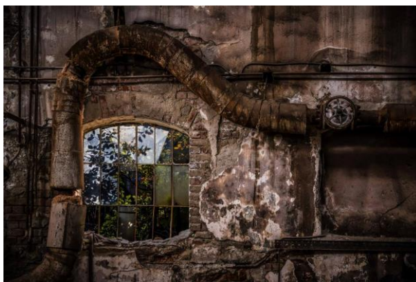
Fig. 20. Interior of the Steaua Română Refinery, Câmpina, România Source: https://proiectsteauaromana-acc.ro/ , photo: Mihaela Tulea
