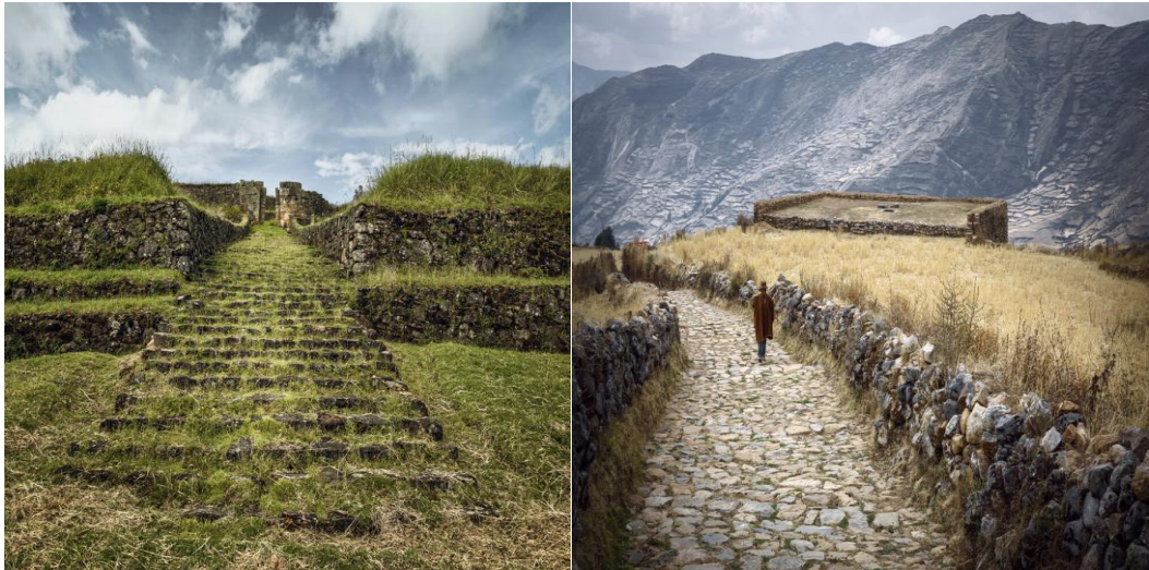
Fig. 20. Stânga – Sistemul Rutier Andin - Zona Arheologică Monumentală Aypate , Dreapta - Sistemul Rutier Andin - Secțiunea traseului Inca în zona Huanuco Pampa - Huamachuco. Drum pietruit de lângă Ushnu din Soledad de Tambo, Ancash.
