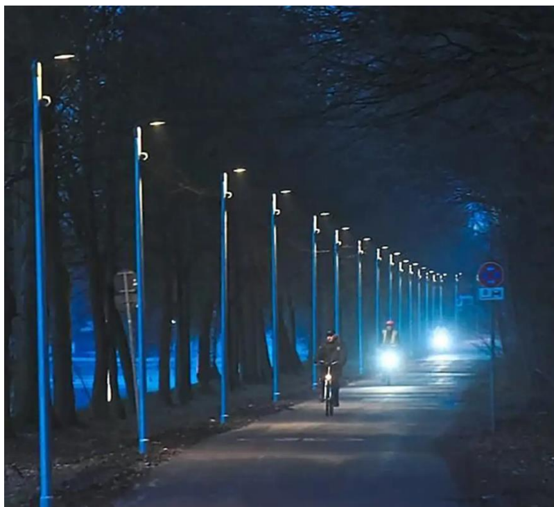
Fig. 6. Iluminat stradal cu senzori de mișcare; Sursa: Smart Street Lighting Smarter Cities [68].
