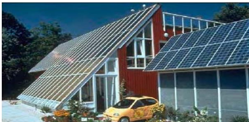
Fig. 7. Panouri fotovoltaice adaptate clădirilor.
